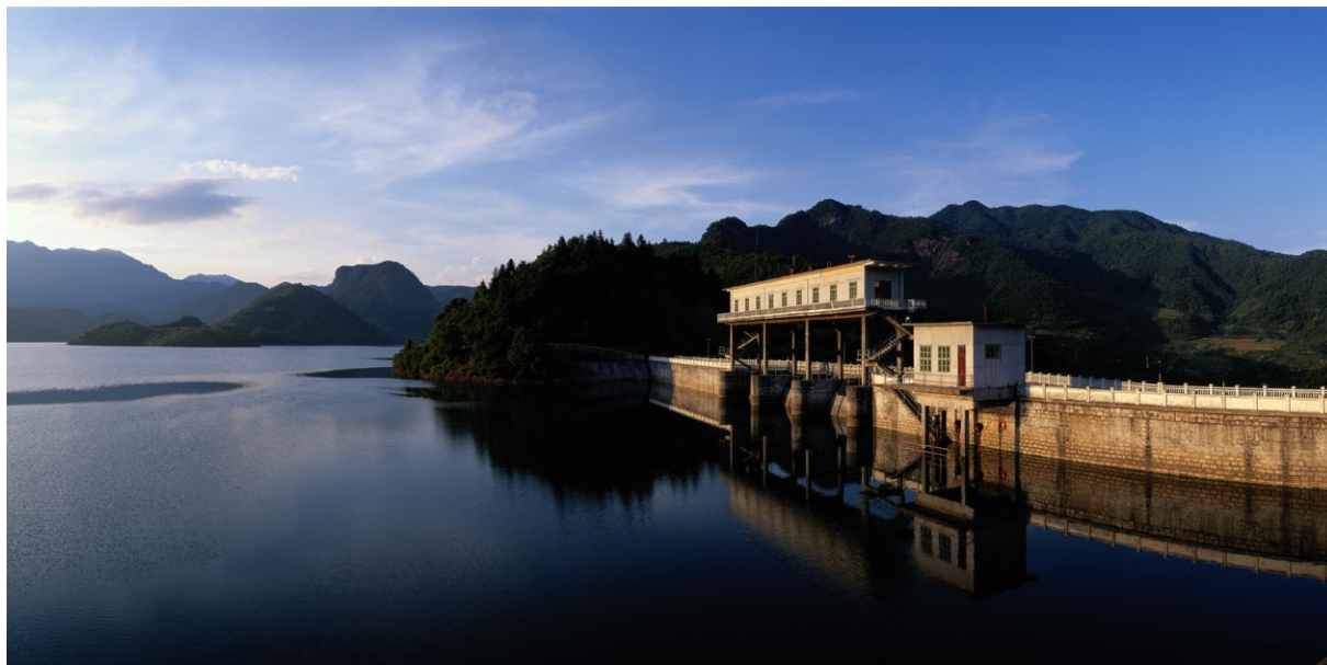
廣東懷集水電站
