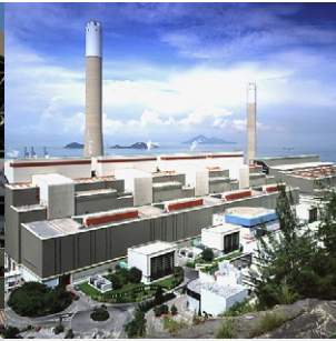
1993 青山發電廠安裝 低氮燃燒器
