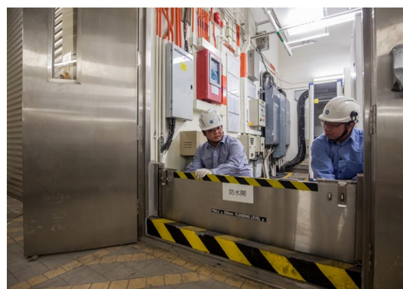
中電為受水浸威脅的變電站加裝防水閘。
