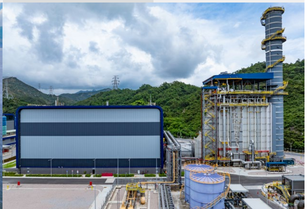
2024 龍鼓灘發電廠 第二台新燃氣發電機組投入運作
