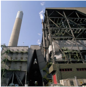
1990 青山發電廠 安裝靜電除塵器
