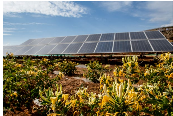
雲南西村太陽能光伏電站
