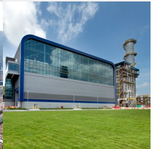
2020 龍鼓灘發電廠首台 新燃氣發電機組投入運作
