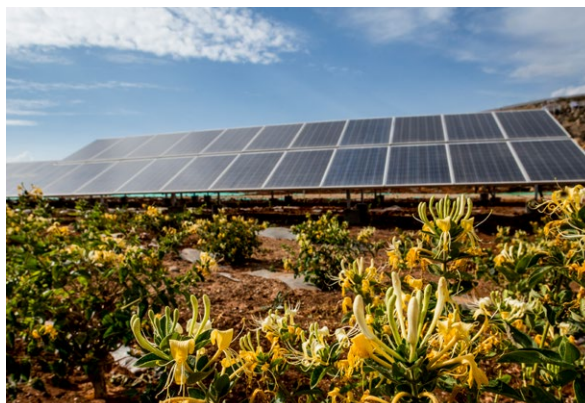
雲南西村太陽能光伏電站
